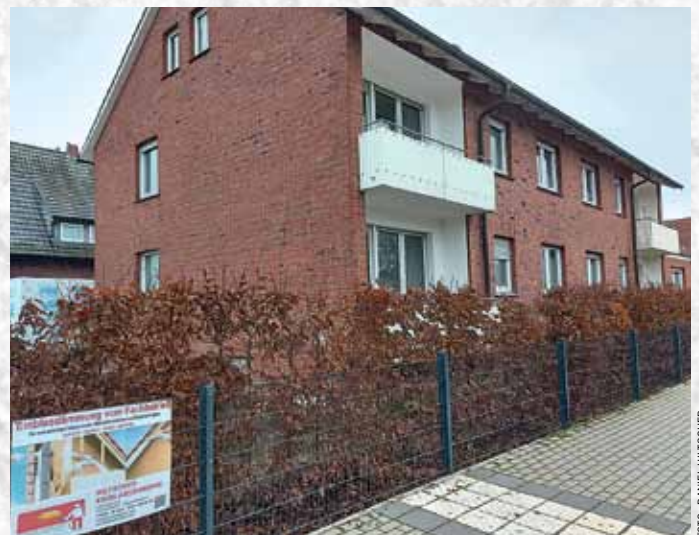
Ein Sechs-Parteienhaus in Harsewinkel erhält eine Kerndämmung: 25 Euro pro Quadratmeter Wandfläche.
