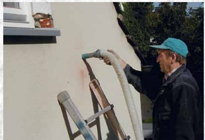
Mittels Luftstrom wird rieselfähiges Dämmmaterial in die Hohlräume zweischaliger Mauerwerkskonstruktionen verfüllt.
