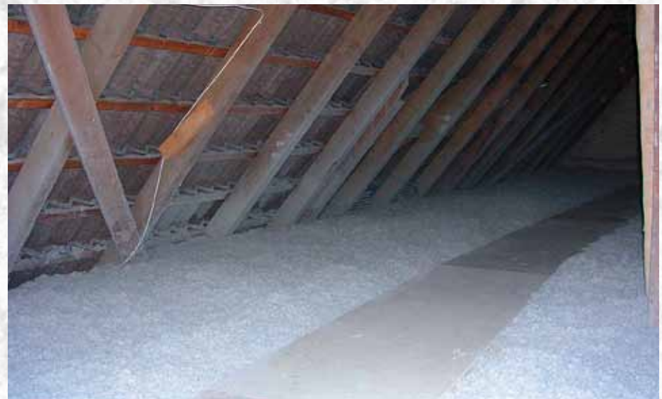
Oberste Geschossdecke mit 40 Zentimeter Dämmung und Laufsteg: Dämmflocken können ohne Abdeckung aufgeblasen werden.
