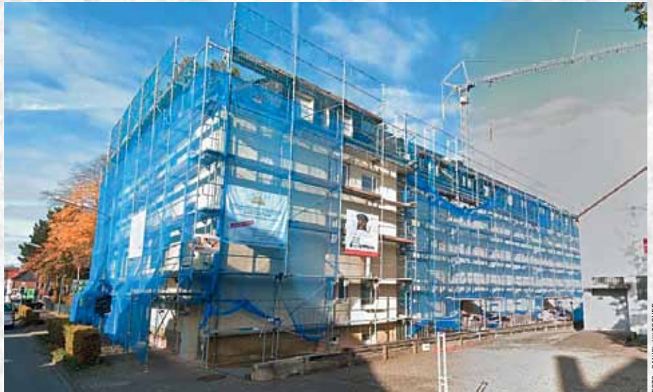
Kerndämmung an zwei Mehrfamilienhäusern einer Lippstädter Genossenschaft: Warmmiete sinkt um 51 Cent pro Quadratmeter.
