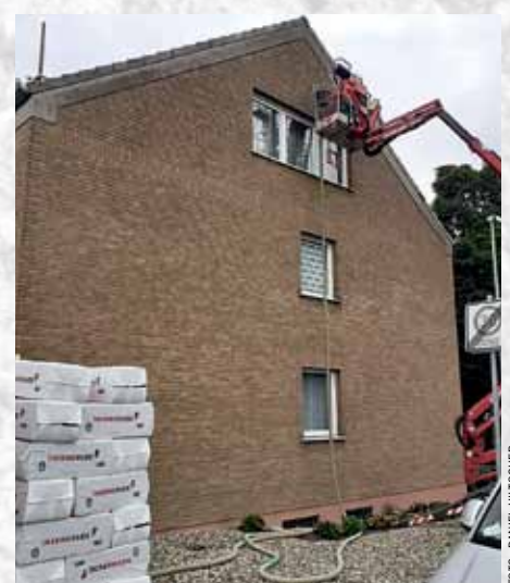
Kerndämmung an einem Acht-Parteienhaus in Beckum: 28 Euro pro Quadratmeter Wandfläche.
